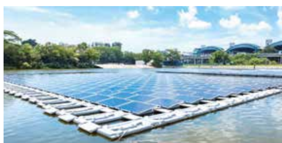
Installazioni di pannelli fotovoltaici galleggianti
