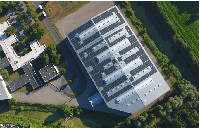
KLEVE, DEUTSCHLAND 749 kWp
