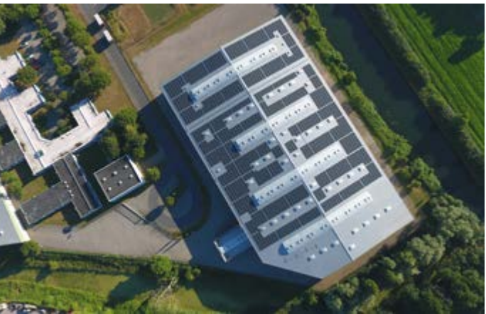
KLEVE, ALLEMAGNE 749 kWp
