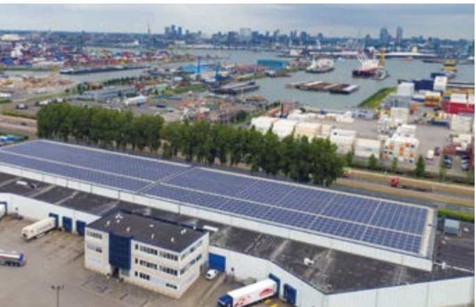
ROTTERDAM, PAYS-BAS 822 kWp
