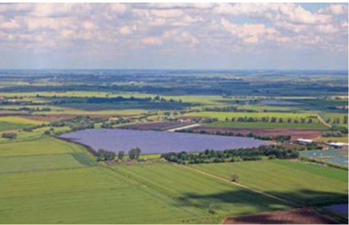
STOWBRIDGE, ROYAUME-UNI 24,3 MWp
