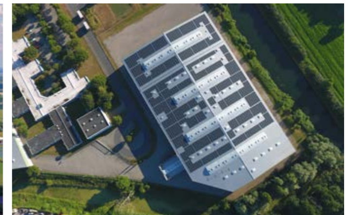
KLEVE, GERMANIA 749 kWp
