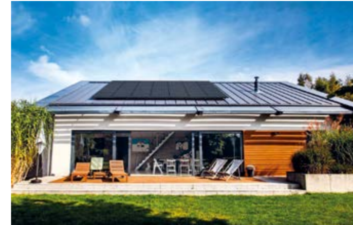
JUNONY, POLONIA 6,4 kWp
