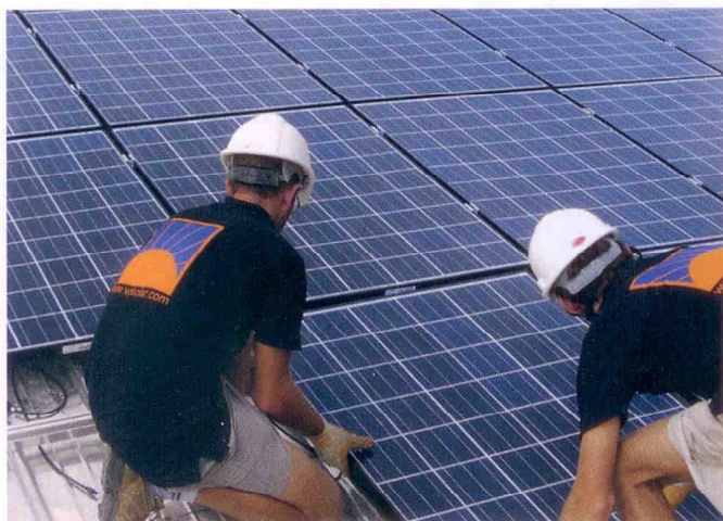
Installazione del sistema di montaggio di VP Solar su un tetto inclinato.
