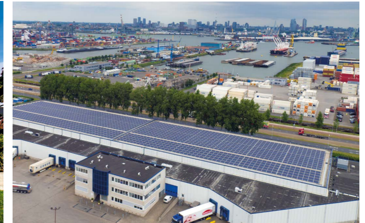
ROTTERDAM, PAESI BASSI 822 kWp
